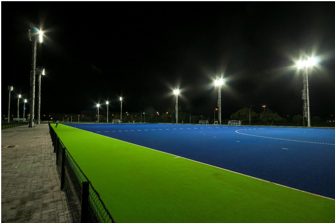
Iluminação Esportiva - CT de Treinamento Olímpico – UFRJ Rio de Janeiro - RJ
