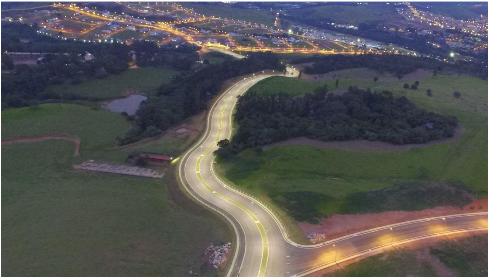
Iluminação Pública LED - Av. Carmelo Scarparo – Itatiba - SP
